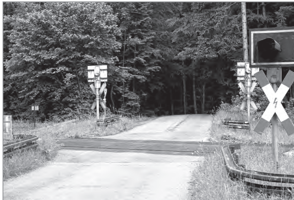
Ein Bild fürs Erinnerungsalbum? Die Überfahrt zur Lauterbacher Mühle wird auf 6,5 m verbreitert und erhält Halbschranken. Foto: tl
