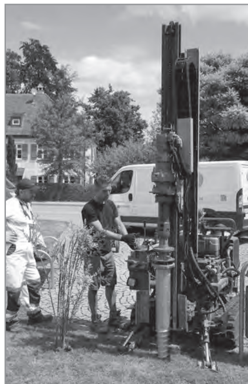
Schweres Gerät zum Einsetzen der Hülse für die Solarlampe. Foto: tl
