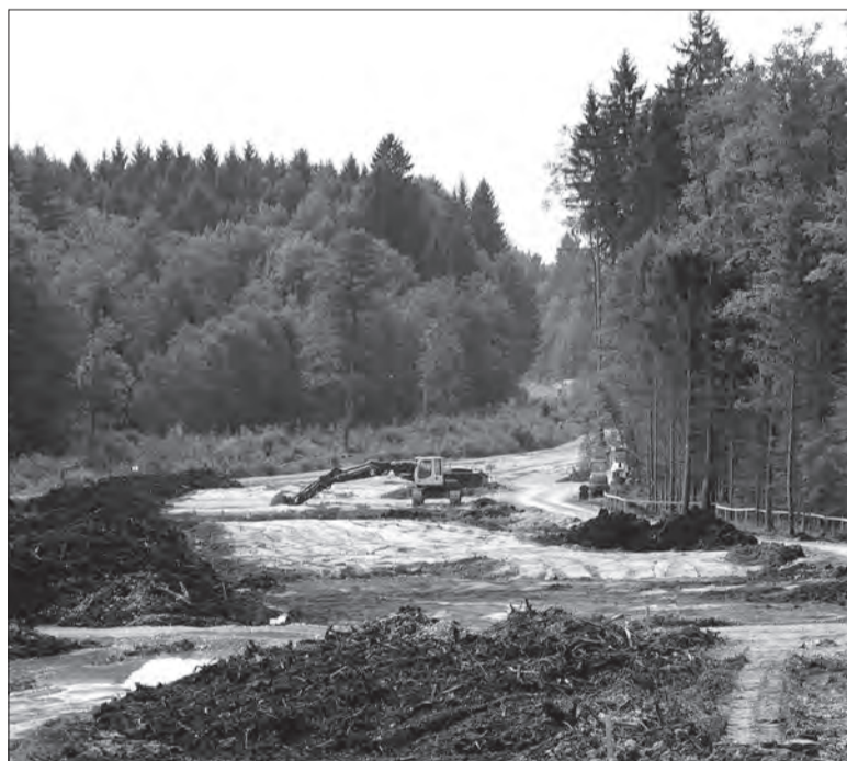
Massiver Einschnitt: Die Bauarbeiten für die neue Staatsstraße nach Bernried haben begonnen. Artikel siehe Seite 4, Foto: tl
